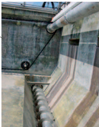
Przebrojenie istniejących urządzeń
